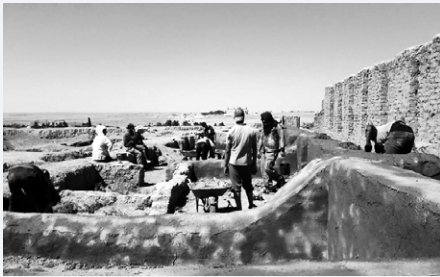
صورة (٧) جانب من أعمال الترميم في الخازن وواجهة المعبد
